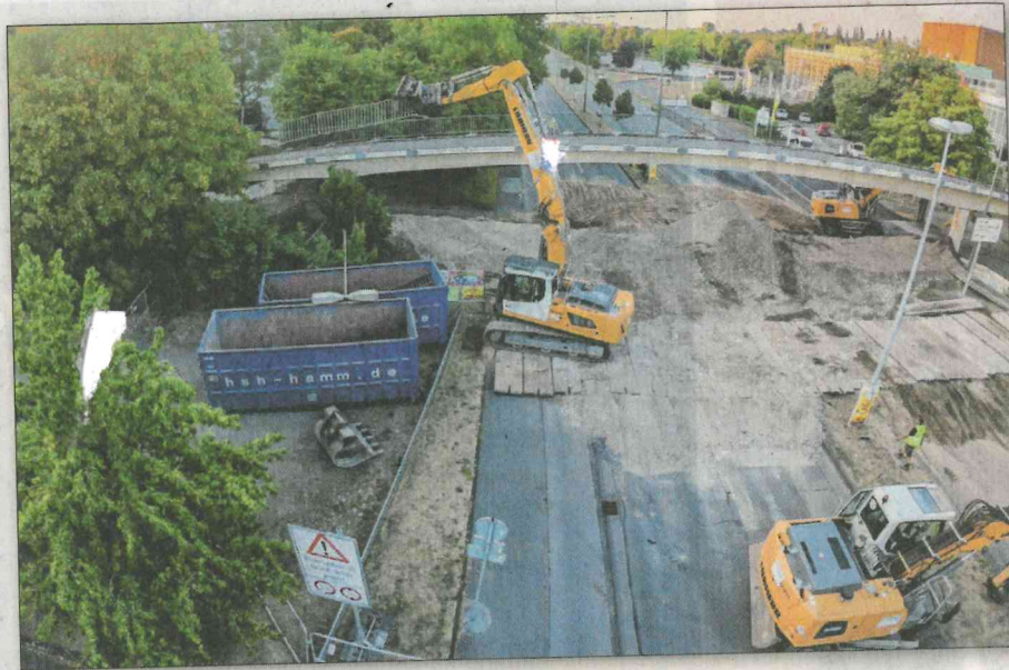
Der Abriss aus der Luft: Erde schützte die Straße vor den Trümmern der Brücke. Foto: Peter Meißner
